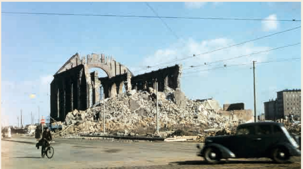
Das Kirchenschiff der Magdeburger Ulrichskirche nach der Sprengung der Türme, Aufnahme April 1956 Foto: Archiv Heiko Schmietendorf, Magdeburg
